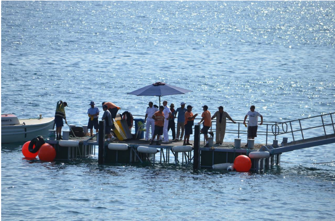
Cascade Jetty Pontoon
